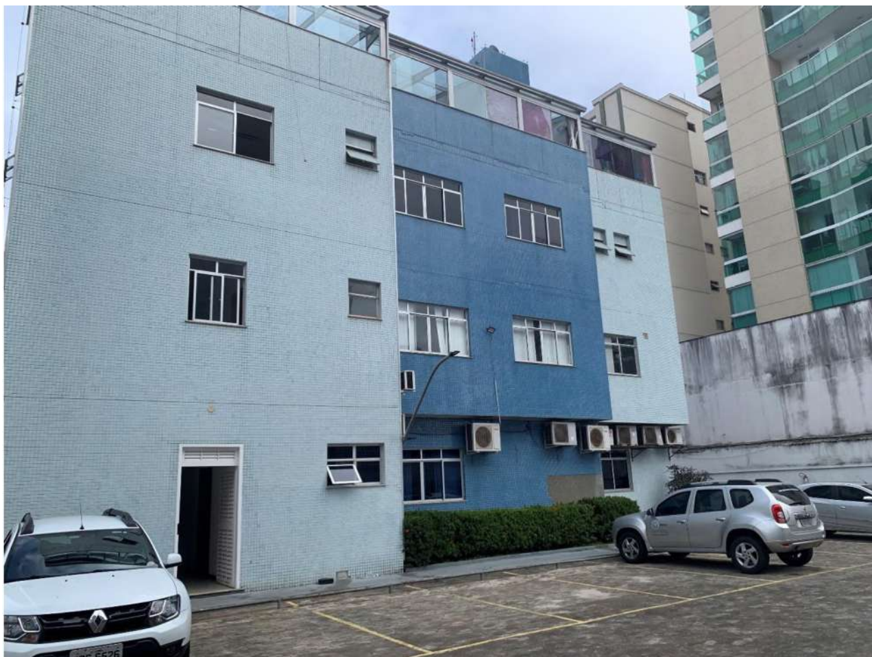
Figura 24 – Nas fachadas não foram encontradas anomalias significativas.
