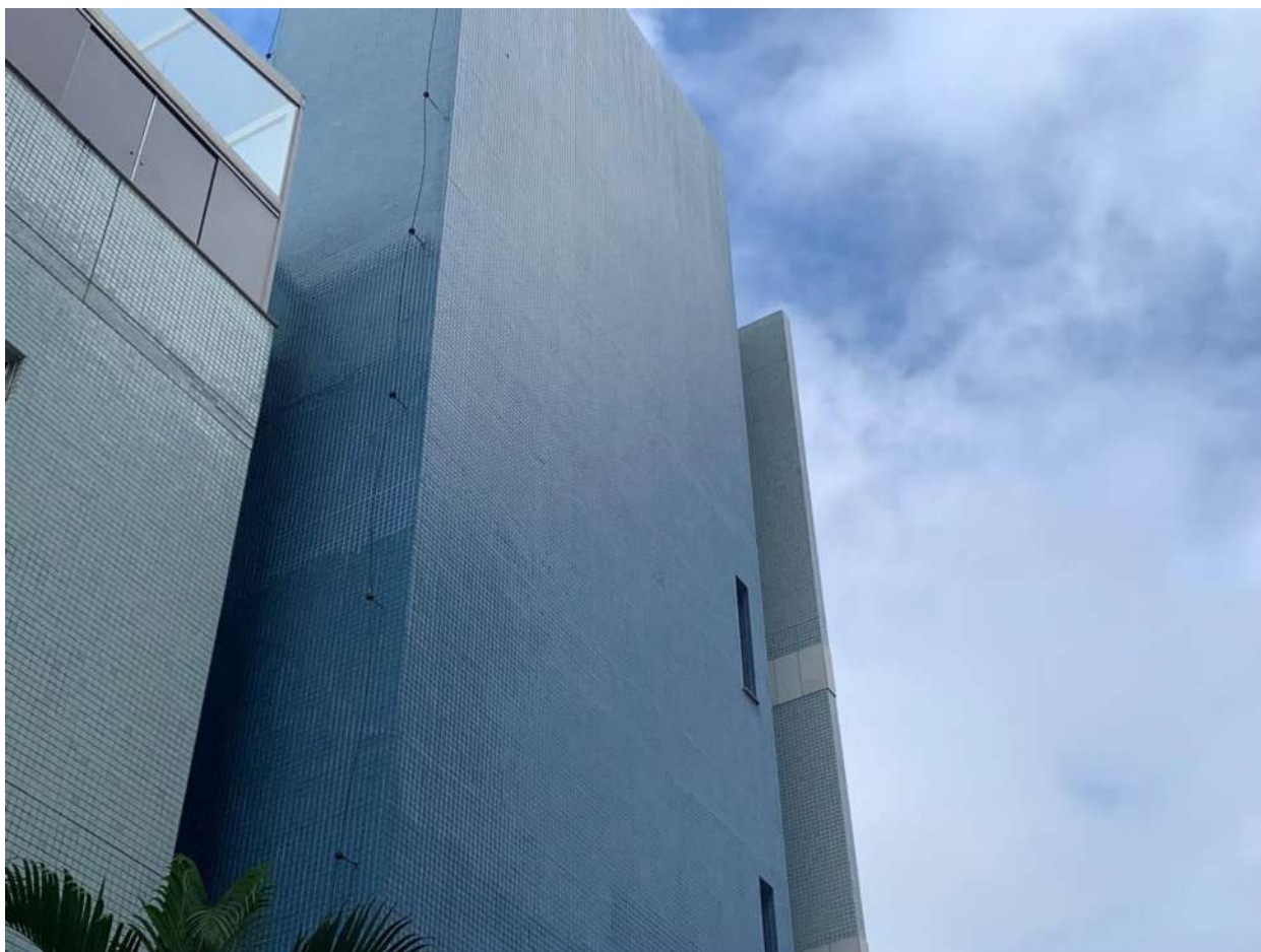
Figura 26 - Nas fachadas não foram encontradas anomalias significativas.
