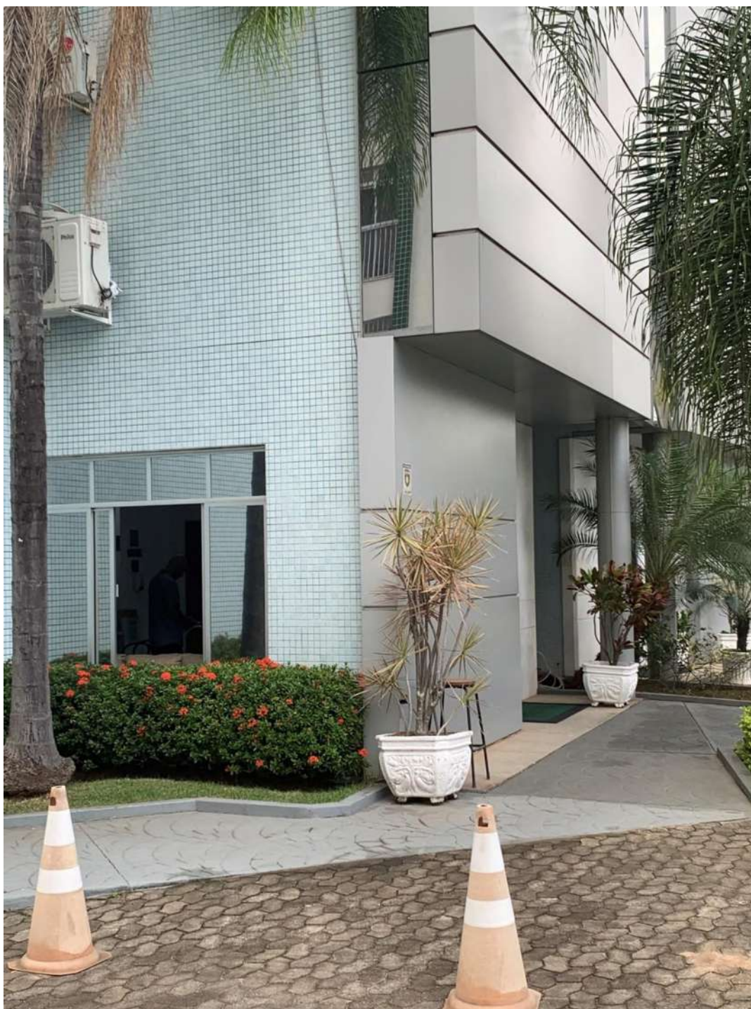
Figura 27 - Figura 26 - Na fachada frontal não foram encontradas anomalias.
