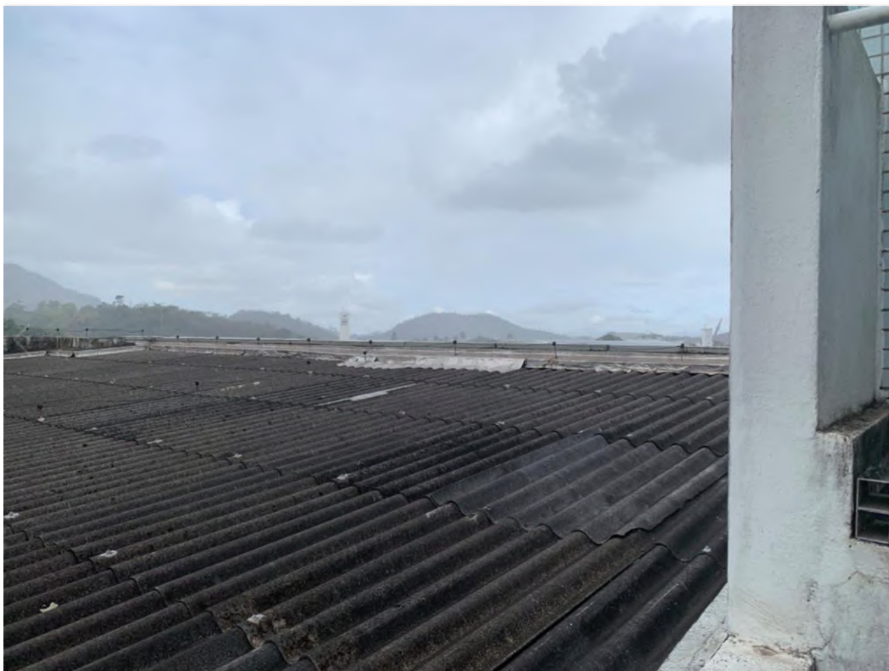
Figura 14 - Na cobertura não foram identificados furos no telhado, nem vazamentos.
