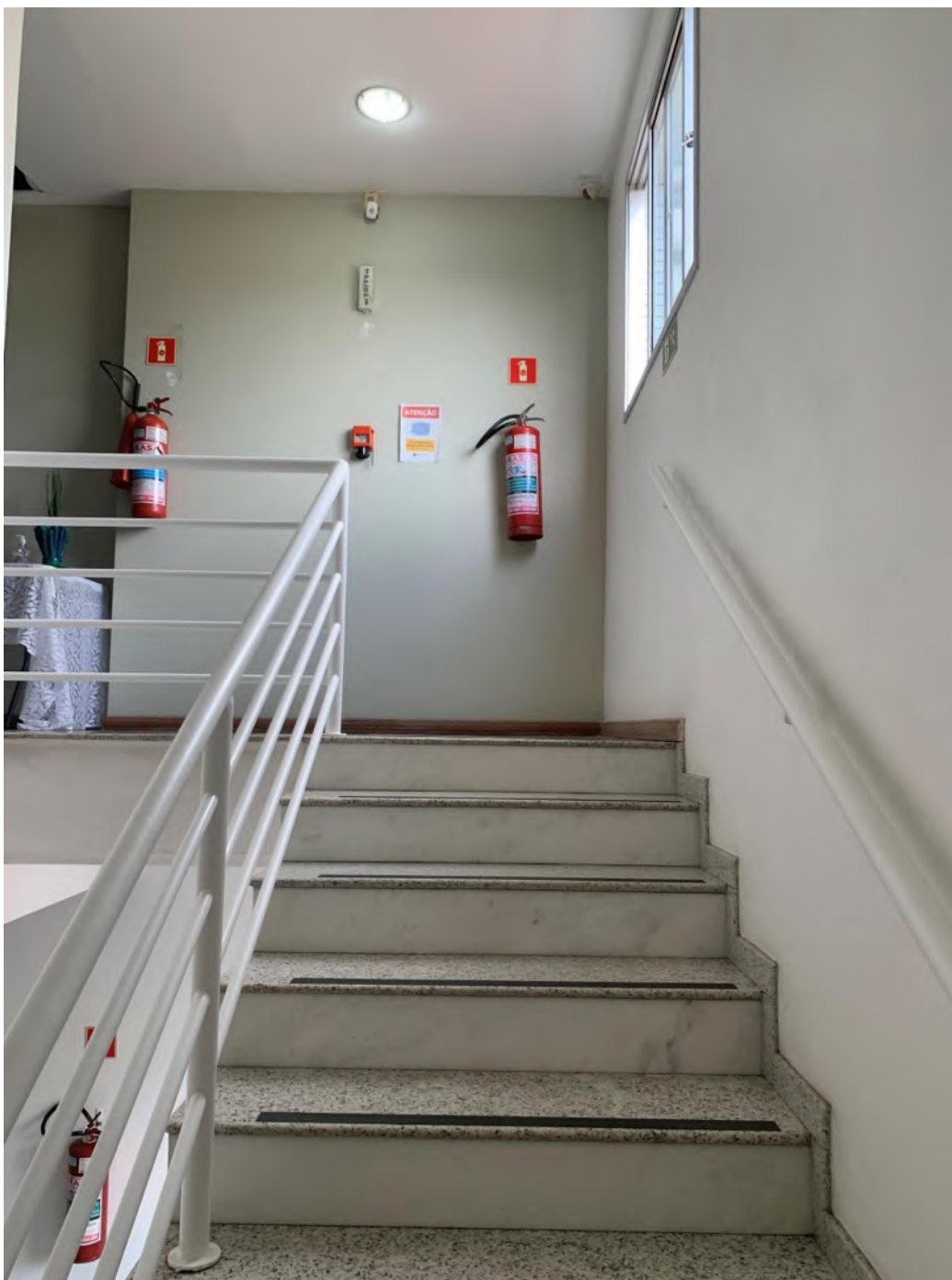
Figura 20 - Nas escadas de acesso não foram encontradas anomalias.
