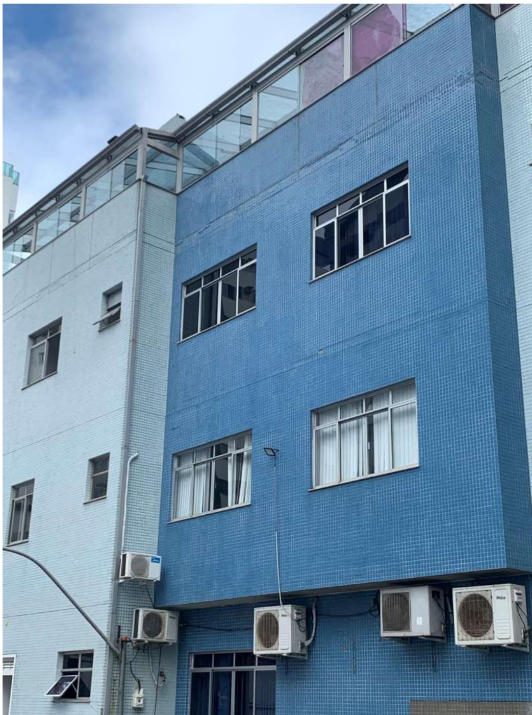
Figura 25 - Nas fachadas não foram encontradas anomalias significativas.
