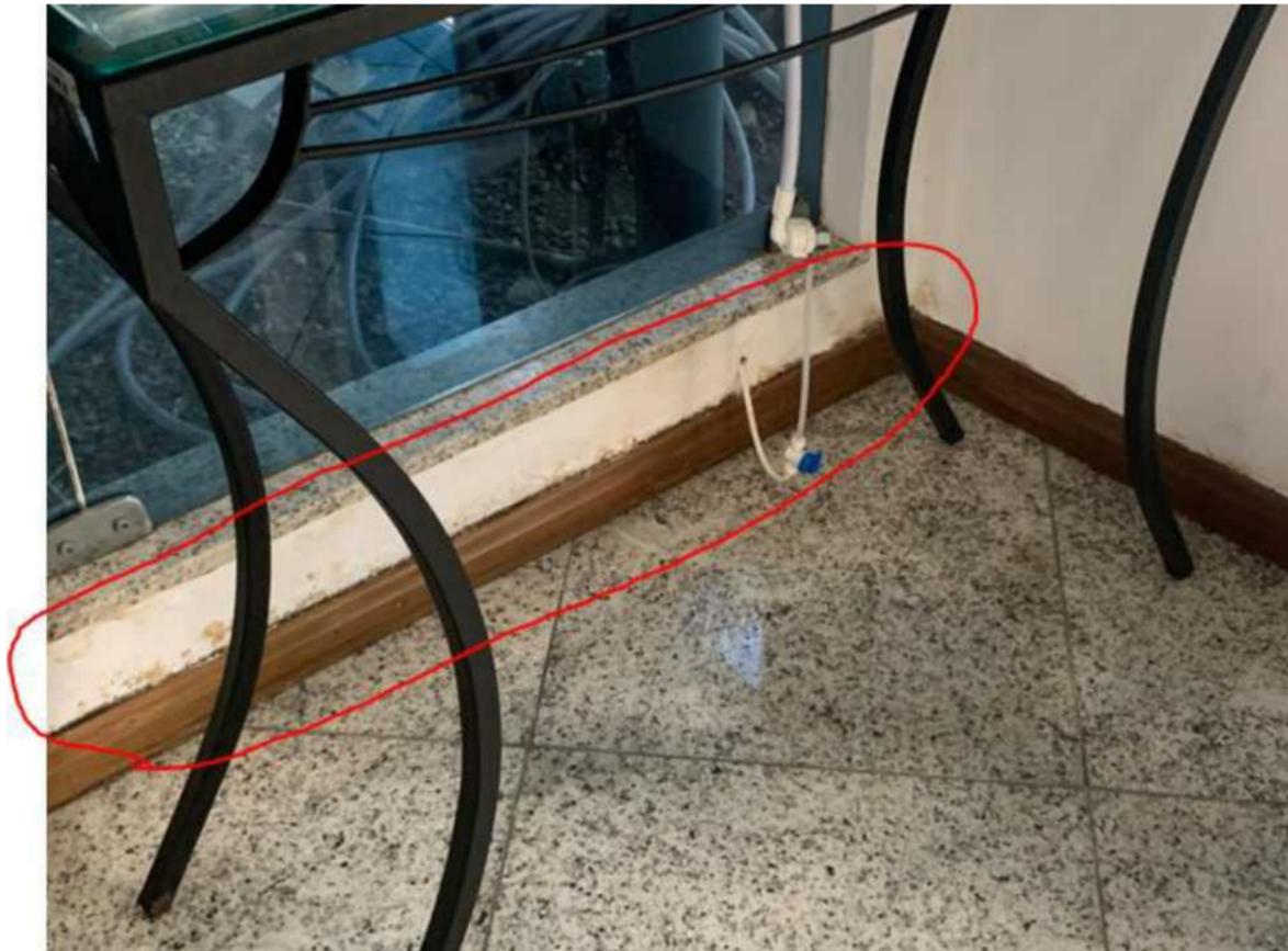
Figura 29 - Foram encontradas anomalias (fissuras, trincas e rachaduras) demarcado em vermelho. Necessário remoção do revestimento até a alvenaria para verificação visual.
