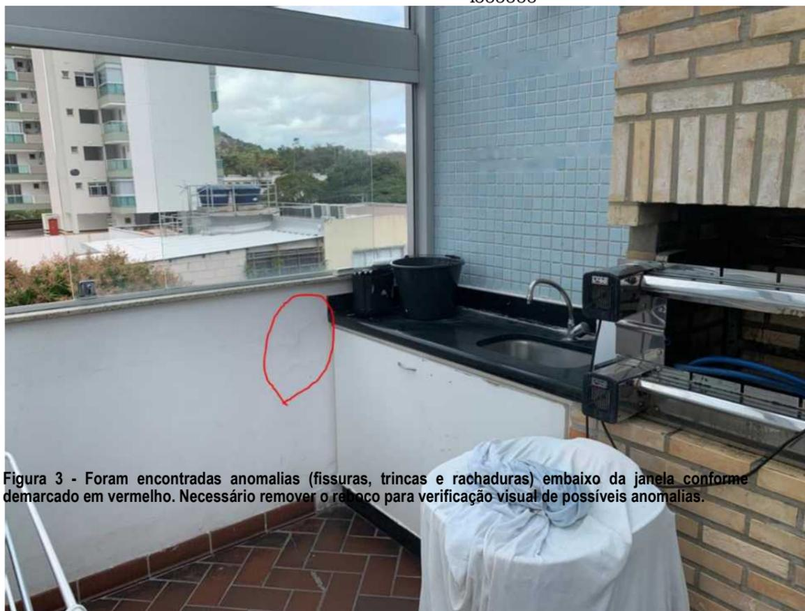
Figura 3 - Foram encontradas anomalias (fissuras, trincas e rachaduras) embaixo da janela conforme demarcado em vermelho. Necessário remover o reboco para verificação visual de possíveis anomalias.
