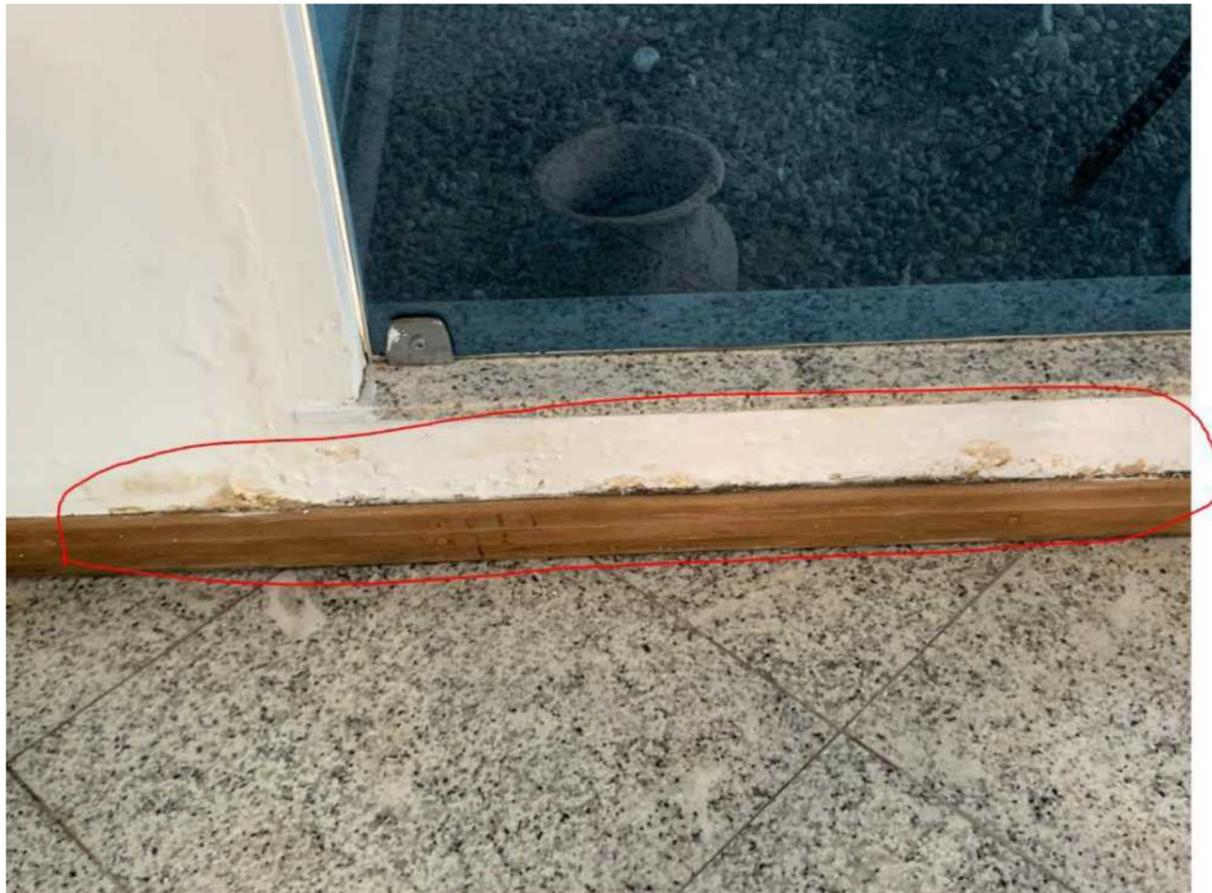
Figura 28 - Foram encontradas anomalias (fissuras, trincas e rachaduras) demarcado em vermelho. Necessário remoção do revestimento até a alvenaria para verificação visual.
