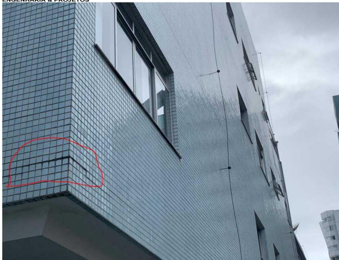
Figura 23 - Foram encontradas anomalias (fissuras, trincas e rachaduras) na fachada demarcado em vermelho. Necessário remoção do revestimento até a alvenaria para verificação visual.
