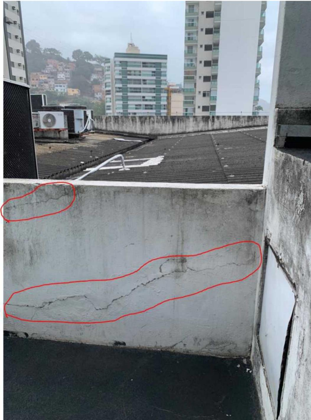
Figura 13 - Foram encontradas anomalias (fissuras, trincas e rachaduras) no parapeito demarcado em vermelho. Necessário remoção do revestimento até a alvenaria para verificação visual.
