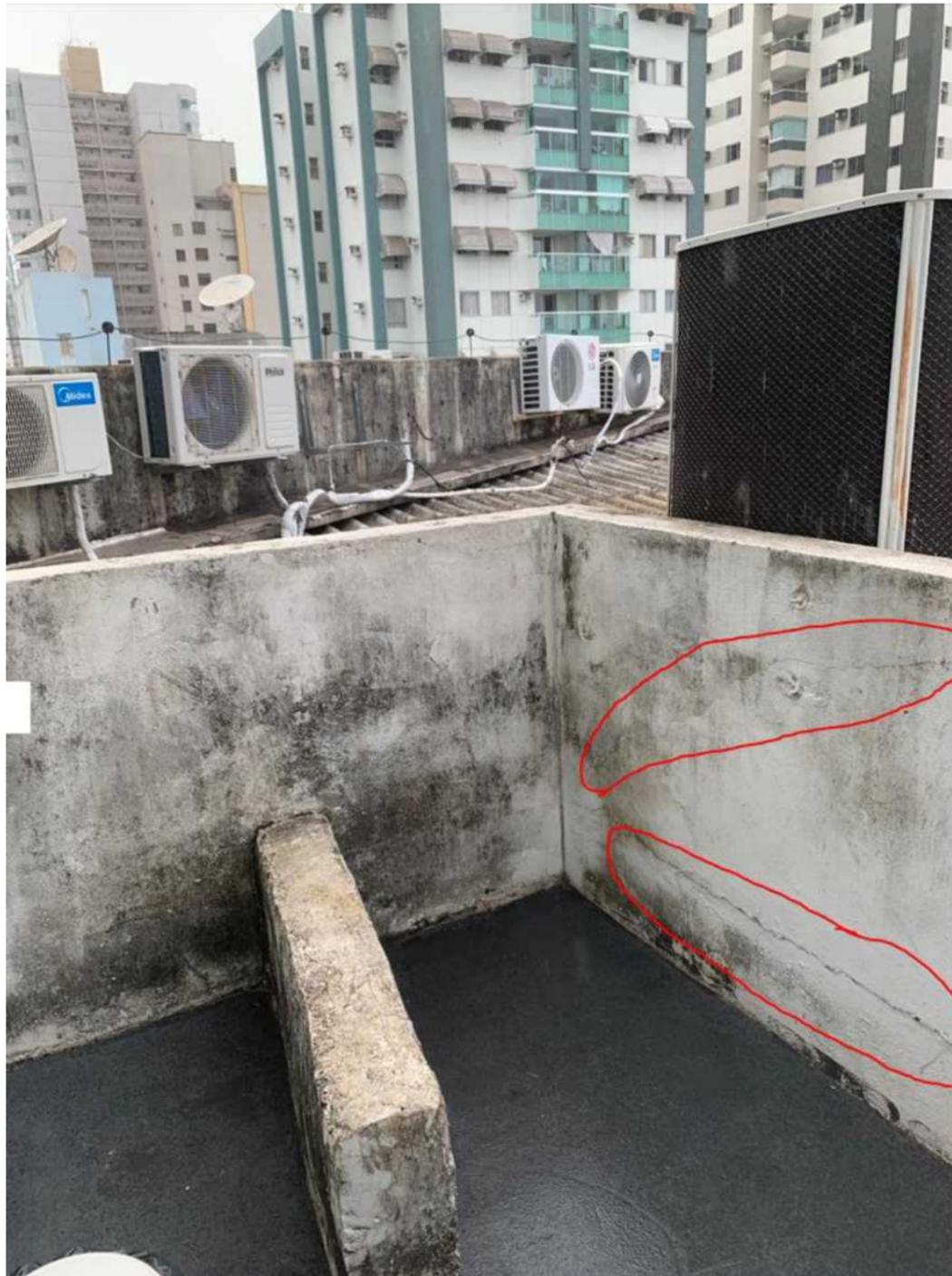
Figura 12 - Foram encontradas anomalias (fissuras, trincas e rachaduras) no parapeito demarcado em vermelho. Necessário remoção do revestimento até a alvenaria para verificação visual.
