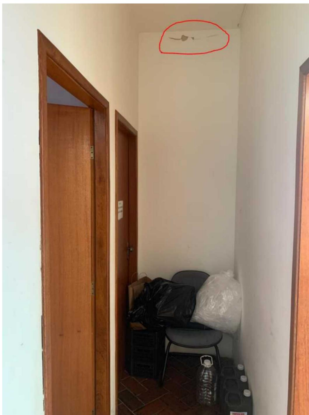
Figura 11 - Foram encontradas anomalias (fissuras, trincas e rachaduras) na parede demarcado em vermelho. Necessário remoção do revestimento até a alvenaria para verificação visual.
